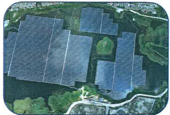
Gambar 4 : Pengapungan solar panel di atas kawasan badan air
