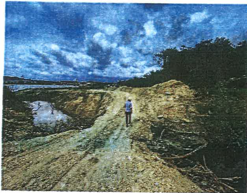
Gambar 2 : Ban sementara yang dibina bagi menghadang kemasukkan air secara terus ke dalam kolam
