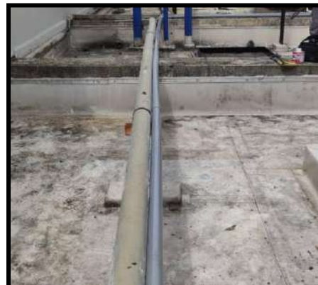
Gambar 1 : Gambar menunjukkan kerja-kerja pemasangan alat peranti Rockson termasuk kerja pemasangan pam dan sistem paip yang berkaitan.
